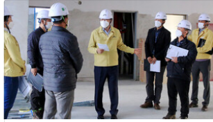
서산시, 국가안전대진단 공사 현장 점검 실시
